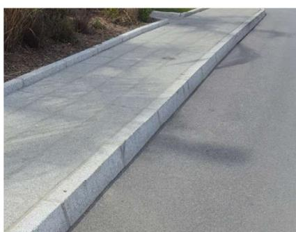
L'intervento da realizzare prevede la sostituzione della pavimentazione con materiale lapideo più precisamente con del granito grigio come materiale identificativo della zona, con un disegno lineare.
